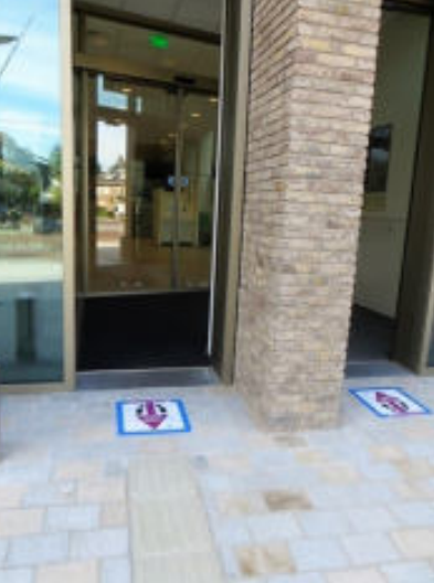
Geleidetegels naar de ingang
